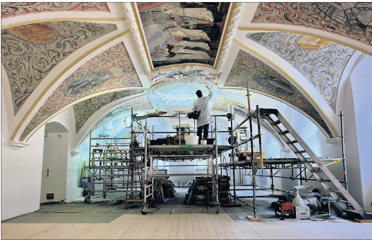
Blick in den Bibliothekssaal während der Restaurierungsarbeiten.
